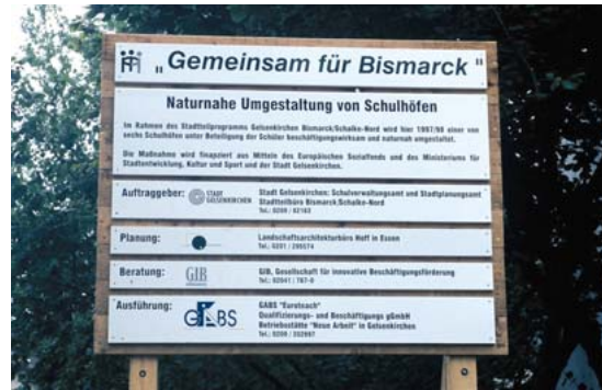
Ein Baustellenschild informiert über die Schulhofumgestaltung. Foto: M. Hoff
