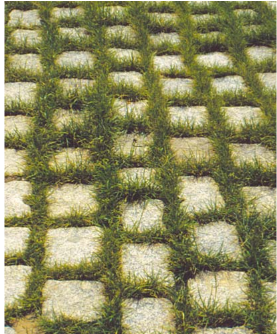
Rasenpflasterflächen ermöglichen das Versickern von Niederschlagswasser. Foto: M. Hoff
