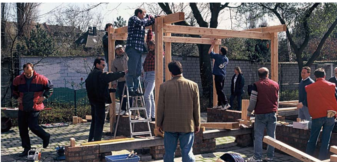
Bauprojekte im Schulgelände erfordern sorgfältige Planung und sind meist nur mit Unterstützung von außen umsetzbar. Foto: M. Hoff
