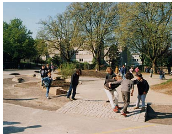
Je nach Witterungsverhältnissen können Mulden-Rigolen-Systeme zur Regenwasserversickerung – wie hier an der Kreuzschule in Dortmund – unterschiedlich genutzt werden. Fotos: H. Knappmann
