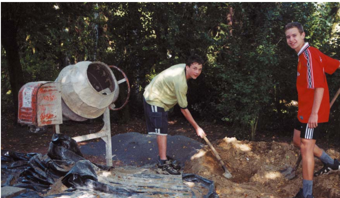
Motorbetriebene Geräte wie z.B. Betonmischer sollten nur von älteren Schülerinnen und Schülern nach sorgfältiger Unterweisung durch die Lehrkraft bedient werden. Foto: Albert-Schweitzer-Schule in Hamm.
