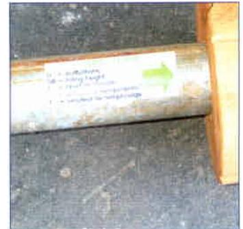
Durch den Pfostenschutz hat das Holz keinen Bodenkontakt . . .
